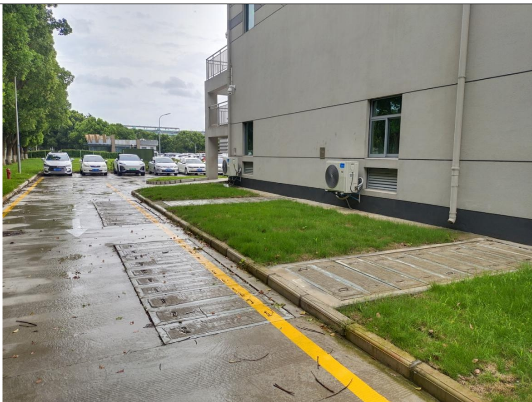
变电站周围的绿化恢复
