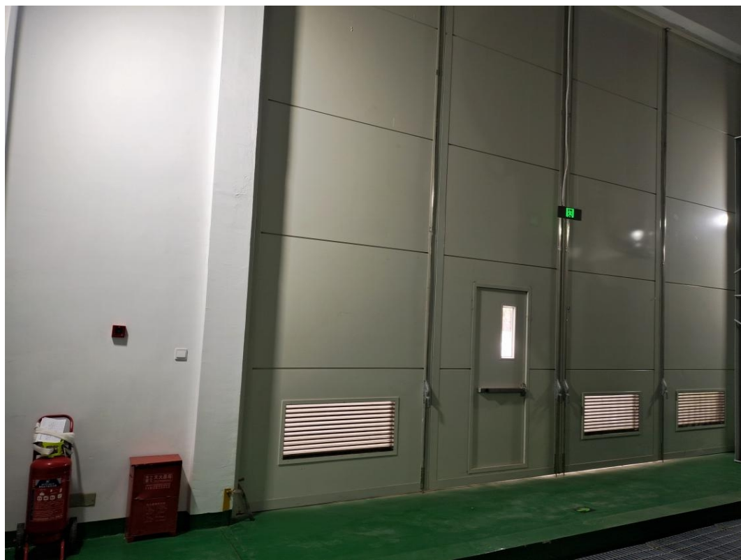
变电站消声百叶窗、隔音门
